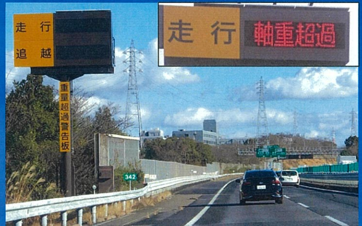
高速道路本線での「軸重超過」表示
